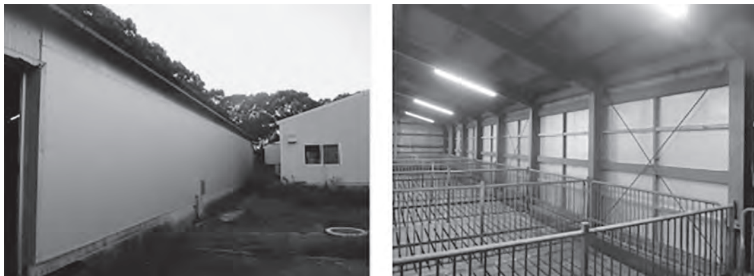
図1 開放型豚舎を閉鎖化した外壁パネル（左）、閉鎖型豚舎の内部（右）
