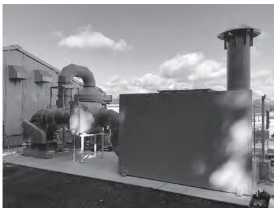
図8 複合式脱臭装置の全体図
