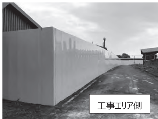
図6 工事エリアと区分する仮囲い設置
