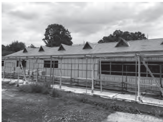
図5 工事中の直接検定豚舎
