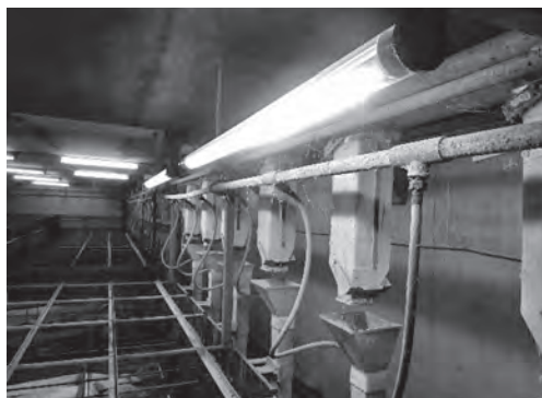
LED照明の高さは床から約1.8m 国産 光の三原色を利用したもの使用
