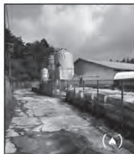
フェンスの設置例
