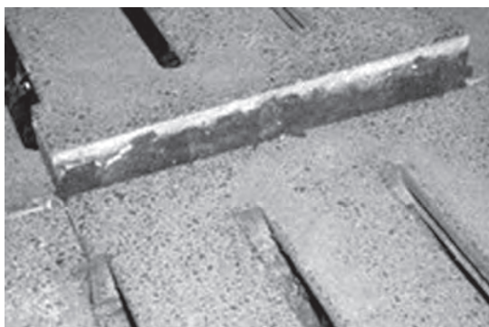
図 1 コンクリスノコ洗浄後の隙間の汚れ
