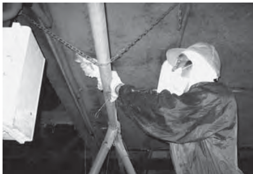
天井ボード剥がし。(写真)
