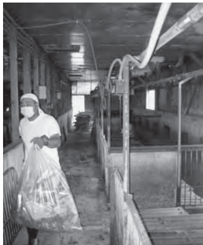
剥がした天井ボード片の片づけ。(写真)
