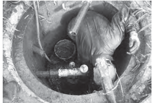
汚水マンホールの汚泥抜き。(写真)
